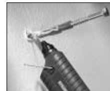
Lockere Dübel befestigen.
